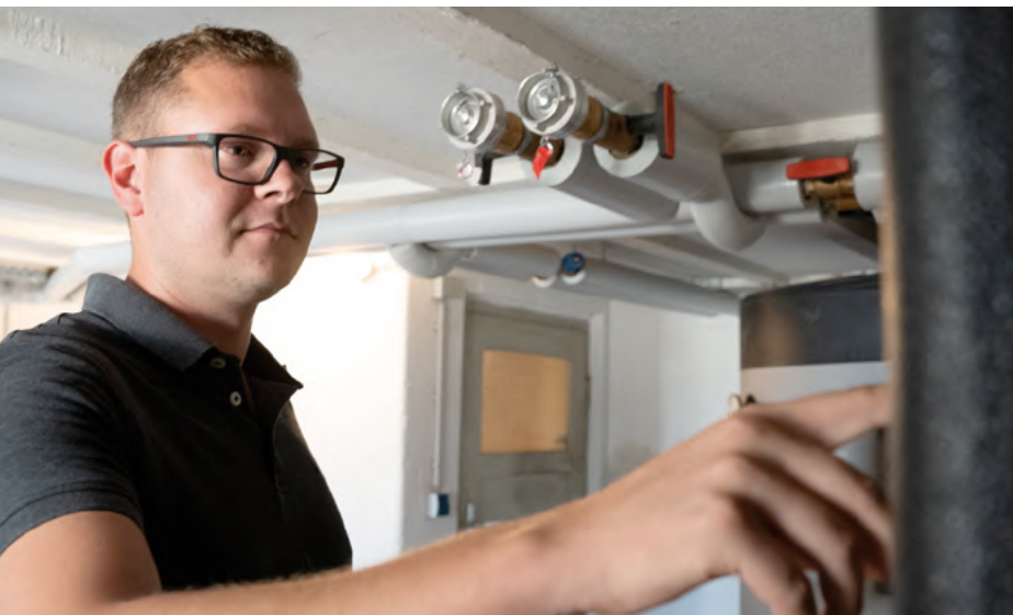
Am Geierweg wird ein nachhaltiges Energiekonzept umgesetzt.
