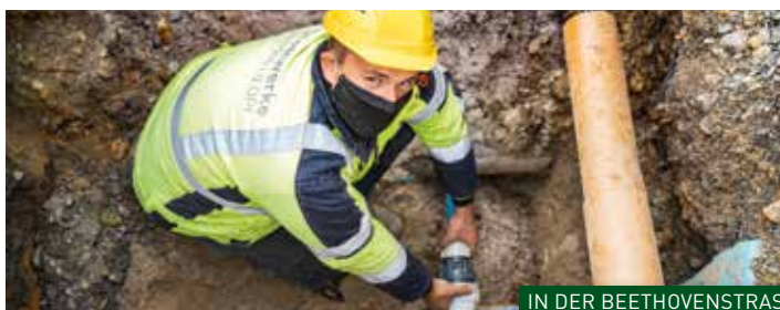
IN DER BEETHOVENSTRASSE STARTETEN IM OKTOBER DIE ERNEUERUNGSMASSENNAHMEN AM GAS- UND WASSERNETZ.
